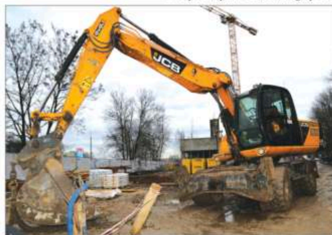
Koparka kołowa JCB JS175W dzięki swej zwartej budowie i dużej zwrotności bardzo dobrze sprawdza się podczas pracy na miejskich placach budowy
